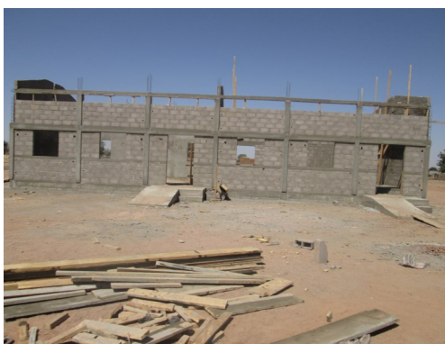
L'école en construction à Djabalène
